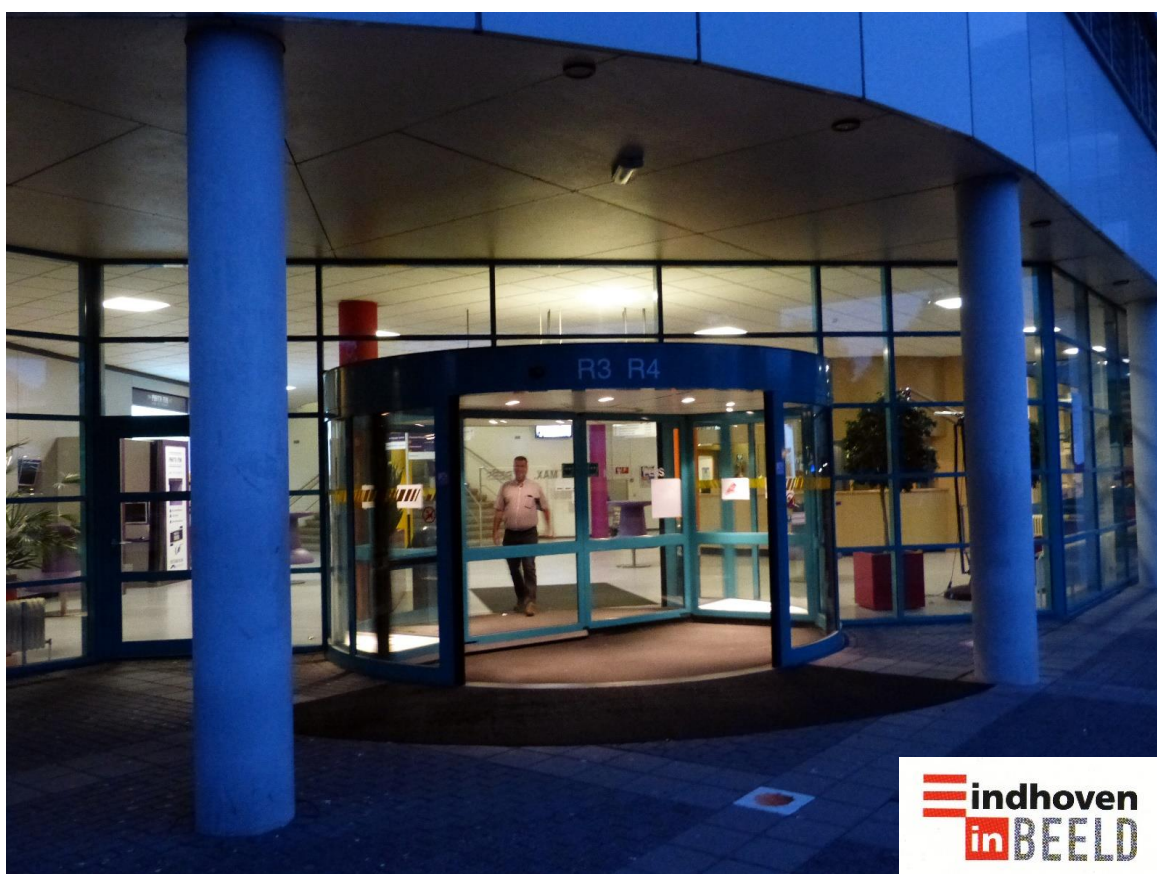
10. Fontys Hogescholen. De ingang van de gebouwen R3 en R4 aan de binnenzijde van de campus.
