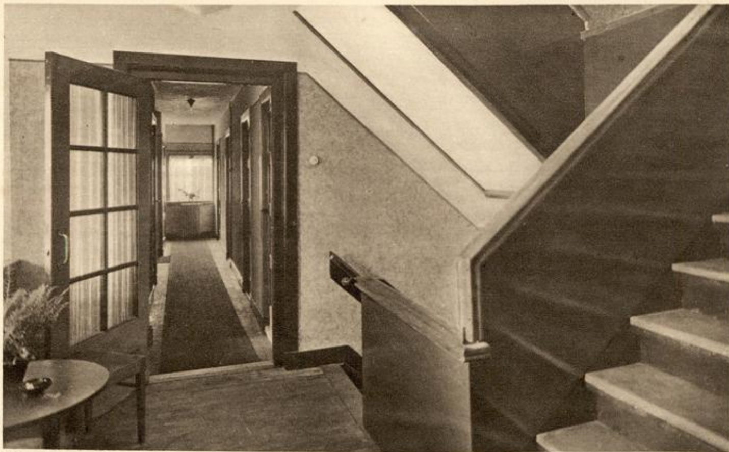
Trappenhuis en gang 1 e verdieping.
